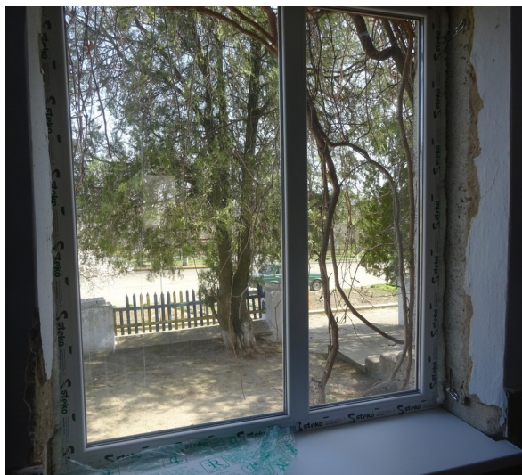
Nya fönster i kontorsbyggnaden
